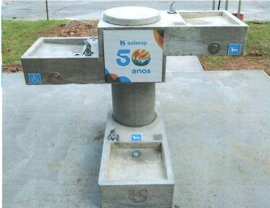
Sugestão de modelo de bebedouro adotado pela SABESP. O exemplar é aparelhado com acessibilidade e hidratação para Pets. O modelo é construído em concreto armado com sistema antivandalismo.
